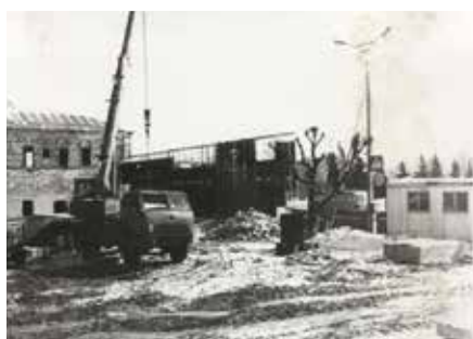
Строительство Дома правосудия
